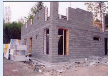
Строительство дома в Финляндии
