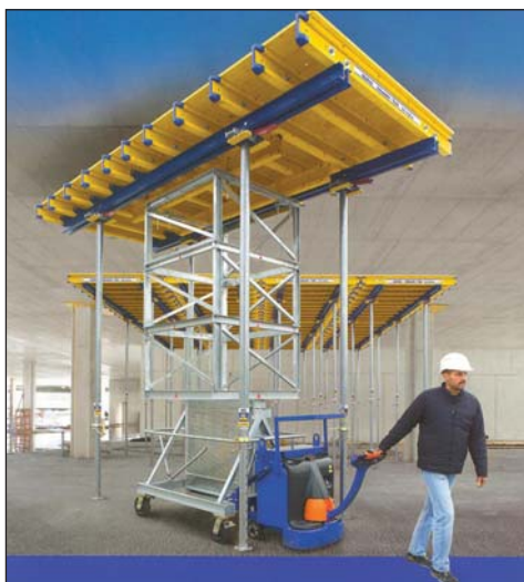
Опалубочный стол Dokamatic-Tisch с приспособлением для его перемещения (задействован только один человек)
