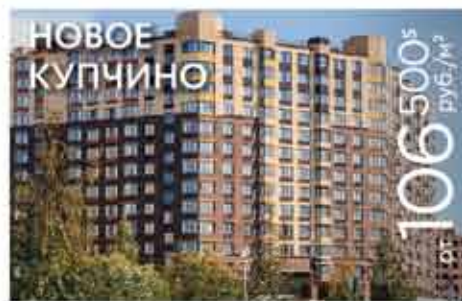
Малая Бухарестская ул./ Дунайский пр-спект «Дунайская» СРОК СДАЧИ: 1 очередь - IV кв. 2020, 2 очередь - IV кв. 2021
