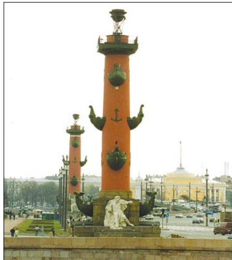
Обследование Ростральных колонн ЗАО «БЭСКИТ» проведено по заданию Дирекции транспортного строительства и Разрешения КГИОП.
