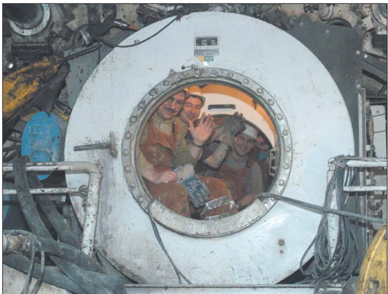
Ликвидацию размыва все чаще в Смольном называют подвигом петербургских строителей
