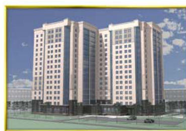
ул. Верности, ул. Карпинского
