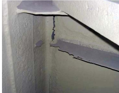
Повреждения металлических конструкций противовесной части Литейного моста в результате электрохимической коррозии
