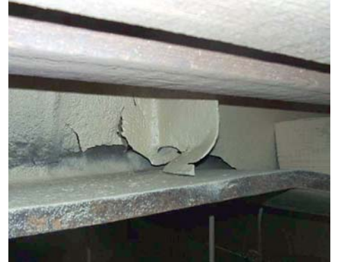
Повреждения металлических конструкций противовесной части Литейного моста в результате электрохимической коррозии
