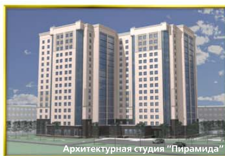
ул. Верности, ул. Карпинского
