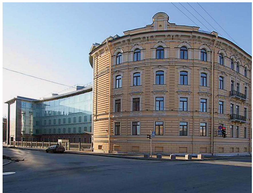
Банковский комплекс ГУ ЦБ РФ по Санкт-Петербургу – победитель конкурса «Лучшее здание, построенное в Санкт-Петербурге в 2004 году»
