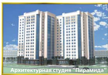
ул. Верности, ул. Карпинского
