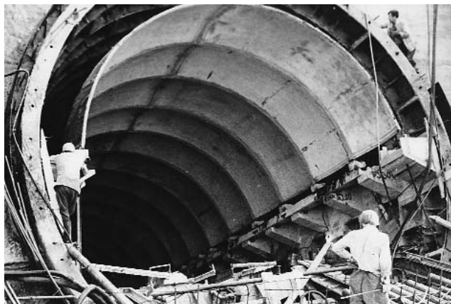
Строительство эскалаторного тоннеля
