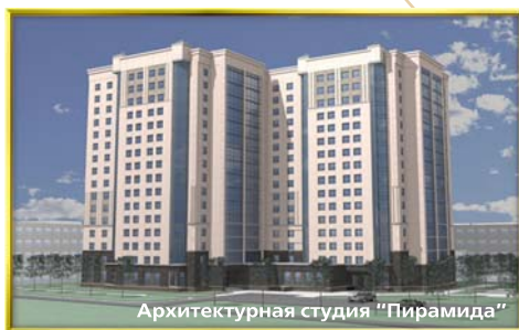
ул. Верности, ул. Карпинского
