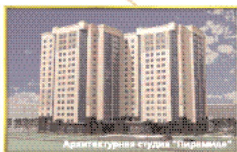
ул. Верности, ул. Карпинского
