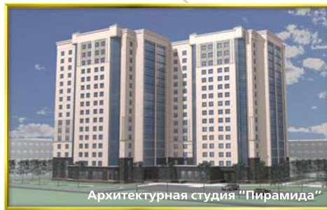
ул. Верности, ул. Карпинского
