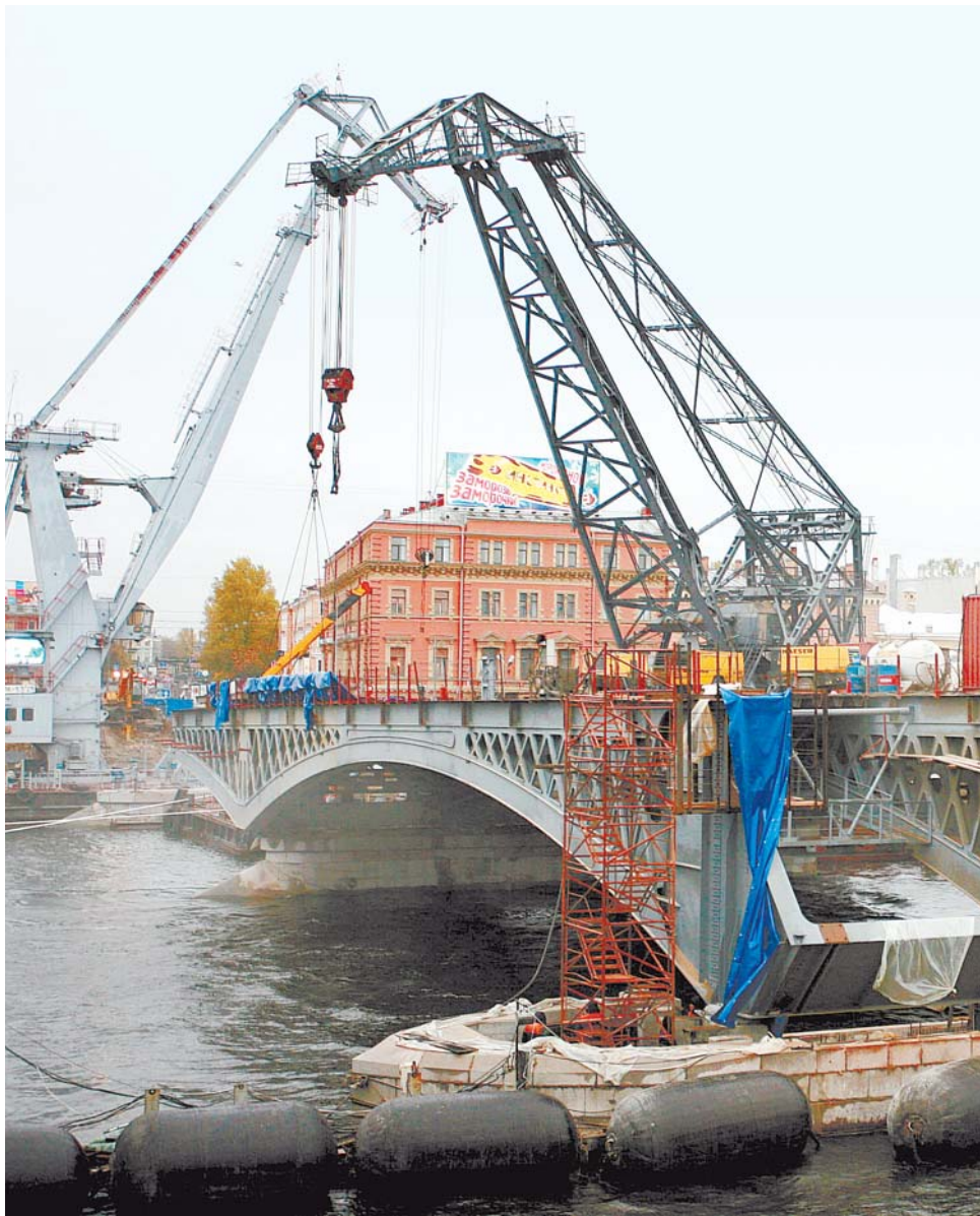
На мосту Лейтенанта Шмидта, который находится на реконструкции, начались работы по установке пролетного строения на постоянные опоры. В ближайшее время предстоит установить еще два пролета. В сентябре 2007 года мост должен быть сдан в эксплуатацию
