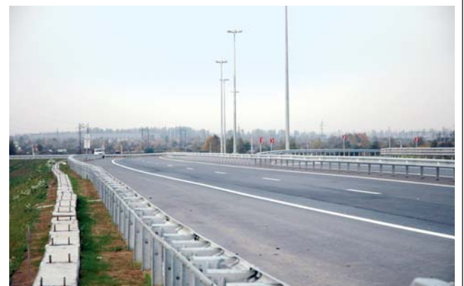
Кольцевая автомобильная дорога
