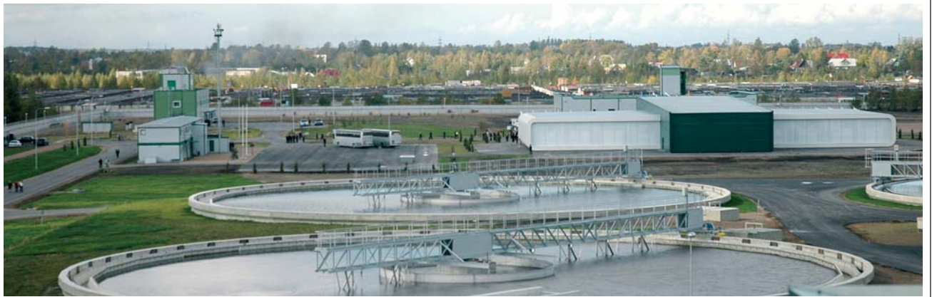
Юго-Западные очистные сооружения
