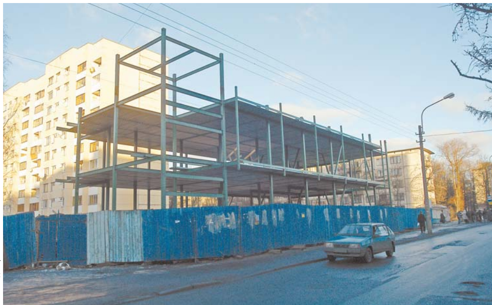
Магазин-кафе в Калининском районе по ул. Замшина. Сейчас каркас здания завершён на 30 процентов
