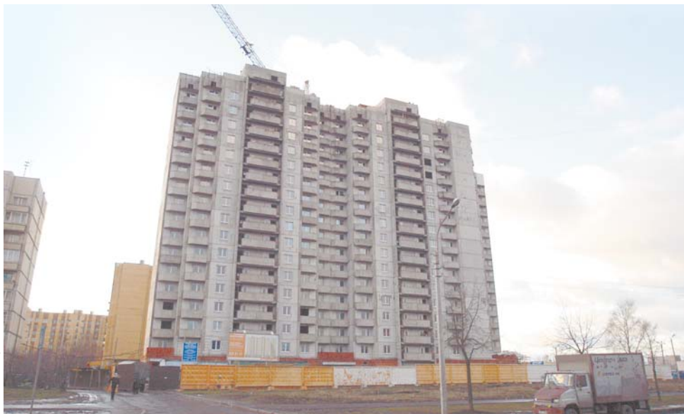
Каркас 17-этажного здания, расположенного по ул. Тельмана, готов на 90 процентов. Застройщик – Гатчинский ДСК
