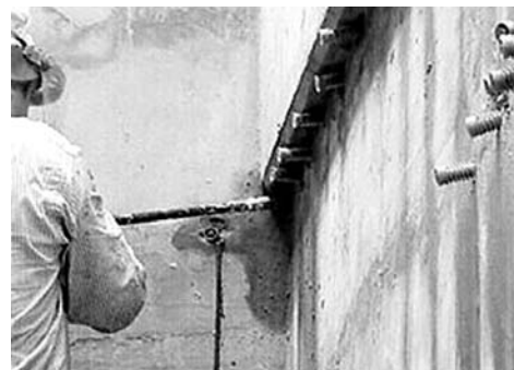
Устройство инъекционной гидроизоляции
