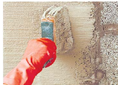
Гидроизоляция подвала
