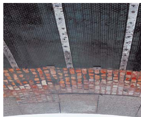
Защитные металлические сетки установлены в местах вывала камней в центральном пролете Аничкова моста через р. Фонтанку
