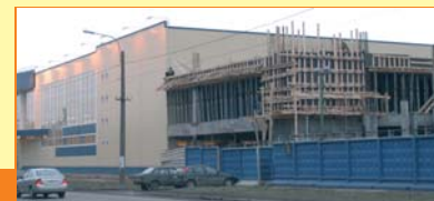
паркинг на ул. Кузнецовская
