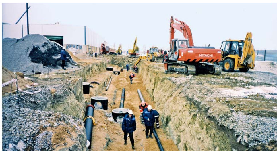
Строительство электронного завода ELCOTEQ
