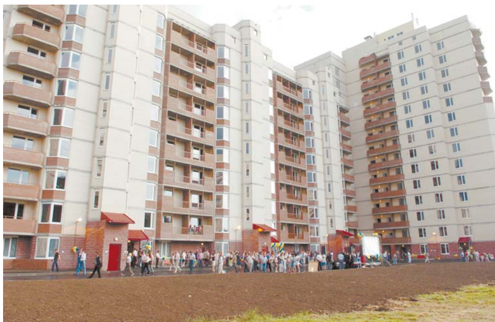
Все квартиры в «Олимпийском» к завершению строительства дома были распроданы
