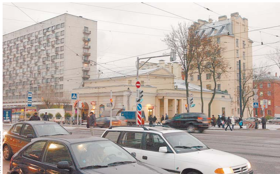
Здания кинотеатра «Север» и общежития теперь пойдут под расселение и снос
