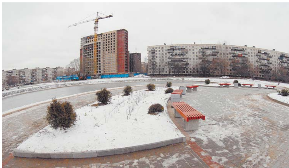
В рамках реконструкции яблоневого сада были не только высажены плодовые деревья, но и проведены работы по устройству дренажной системы, ремонт асфальтового и плиточного покрытий
