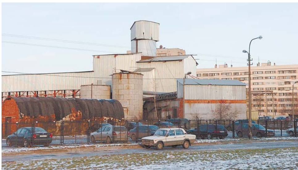
Сейчас в границах земельного участка, предоставленного инвестору, временно размещается строительная площадка метрополитена – метро «Международная»
