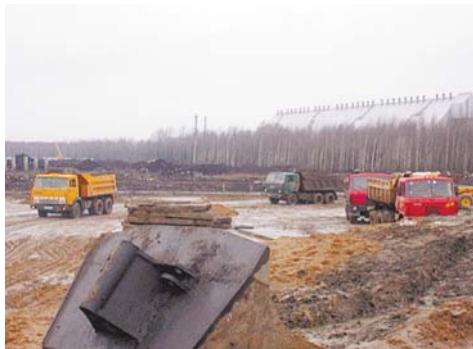
ПЛОЩАДКА ЮГО-ЗАПАДНОЙ ТЭЦ, ОСЕНЬ 2006 ГОДА.
