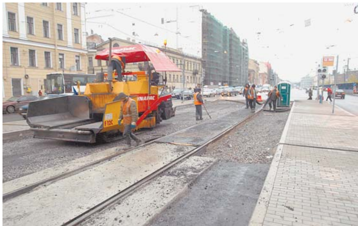
Летом 2007 года было отремонтировано 8 магистралей на Васильевском острове
