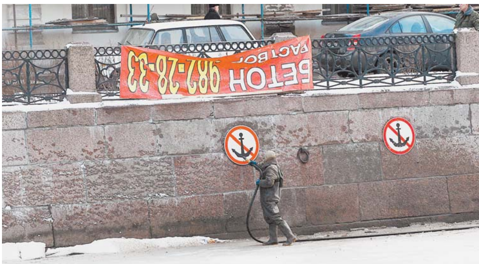
На набережной реки Мойки проводятся пескоструйные работы
