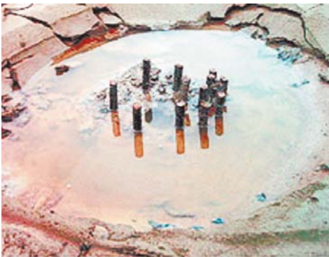
Оседание сваи и поверхности грунта около нее после изготовления
