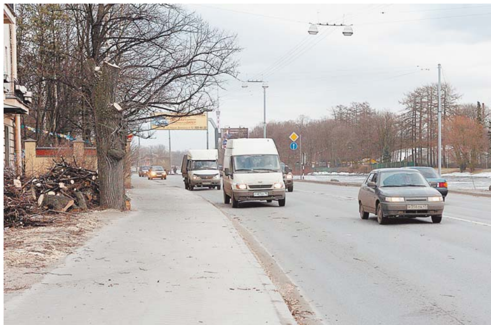
Вырубка деревьев на Приморском проспекте – только начало реализации проекта реконструкции Приморского транспортного узла
