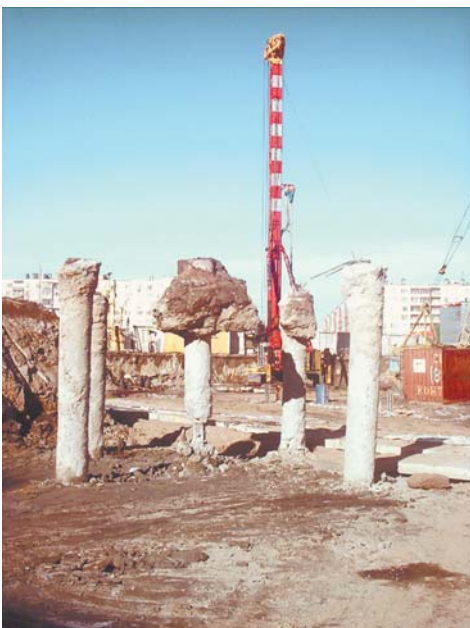
Сваи, выполненные фирмой «Статика» по технологии «Фундекс»
