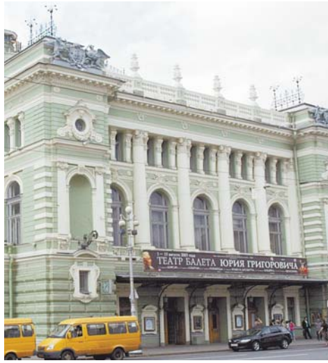
Реставрация театра зависит от строительства новой сцены
