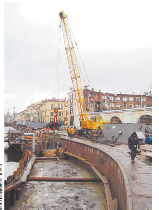
Современные технологии позволяют строить набережные, не нарушая наследия истории
