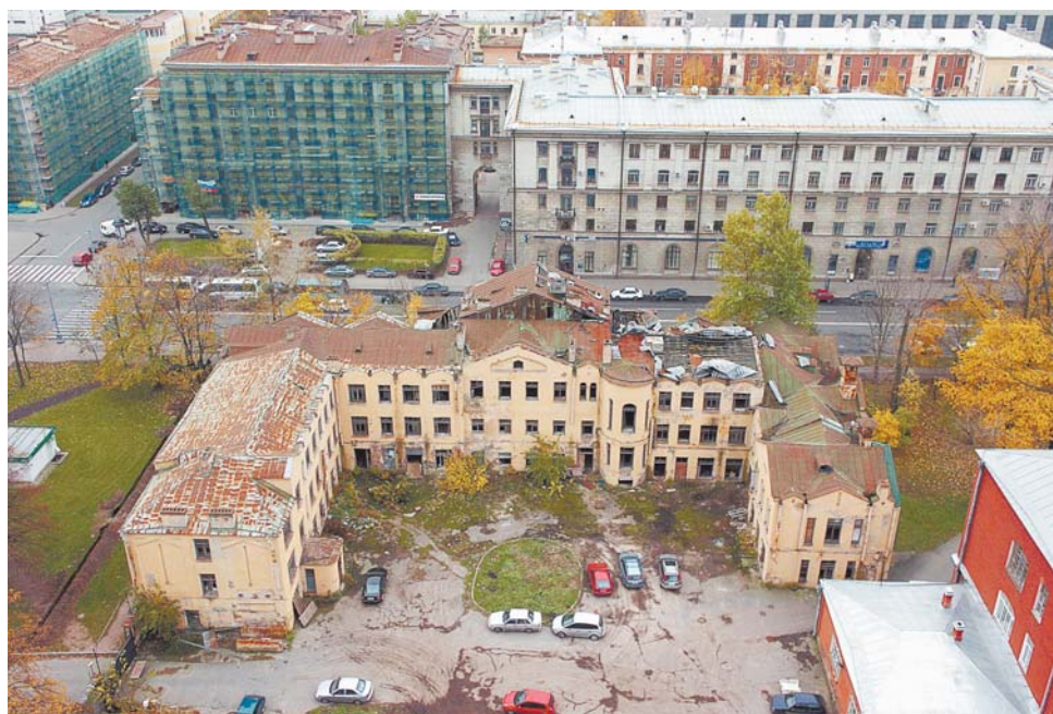
Ветхий неврологический корпус Покровской больницы будет снесен. На его месте построят медико-реабилитационный центр
