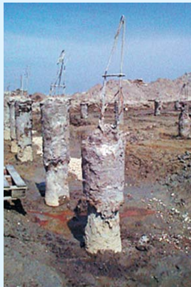
Рисунок 1. Типичные дефекты буронабивных свай
