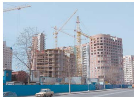
Западнее пересечения Малого проспекта В.О. с Парусной улицей строится многофункциональный жилой комплекс
