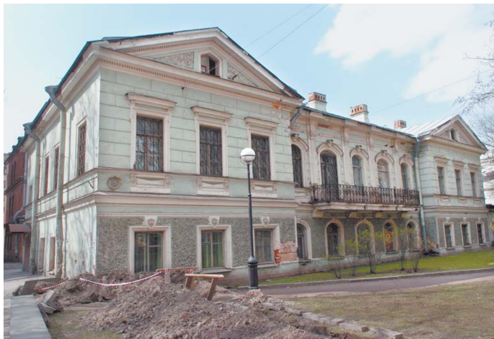
На Каменноостровском проспекте, 58-60, лит. А проводится реконструкция двух особняков
