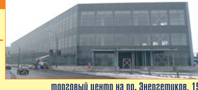
торговый центр на пр. Энергетиков, 19
