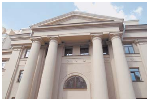
Средняя школа №140 в Красногвардейском районе после капитального ремонта
