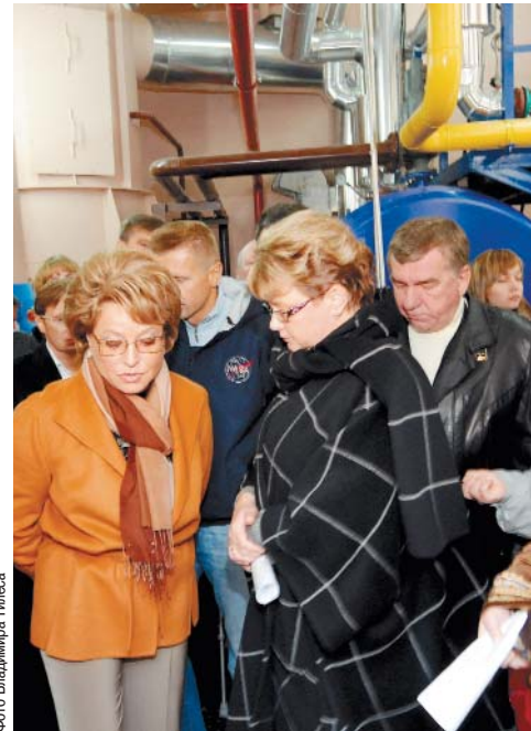
Котельная нового поколения. Их устанавливает в Центральном и Адмиралтейском районах ГУП «ТЭК СПб»
