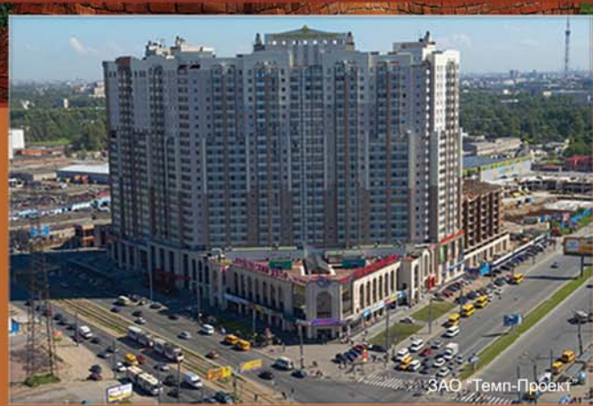
КОЛОМЯЖСКИЙ пр., 15 (IV очередь)
