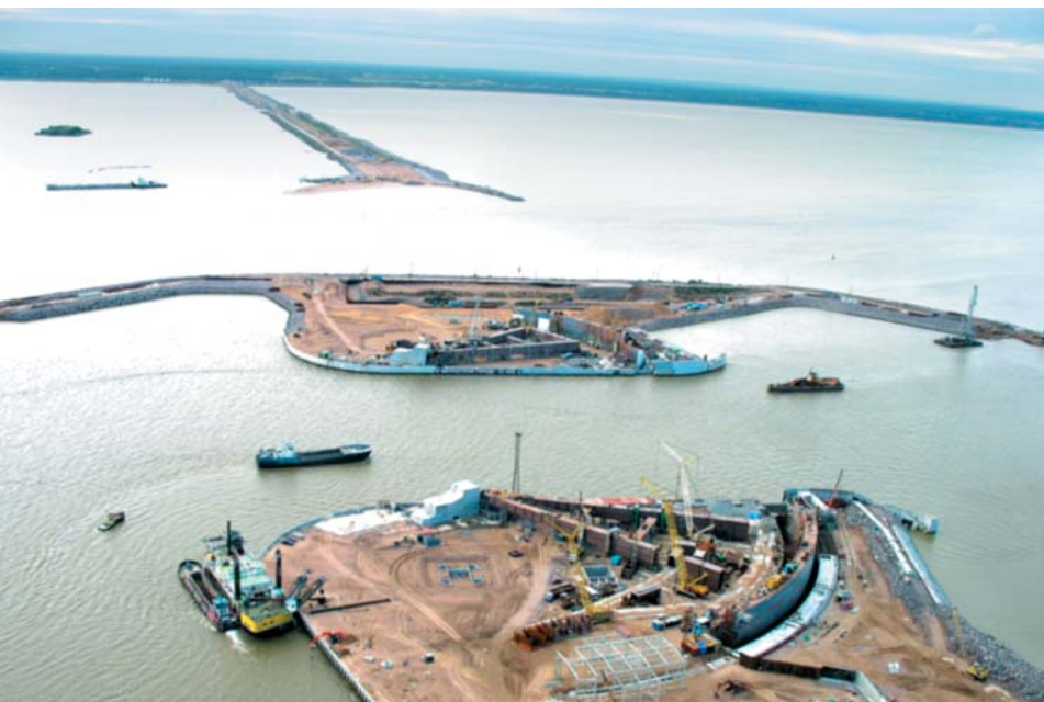
Вид на судопропускное сооружение в сторону Бронки
