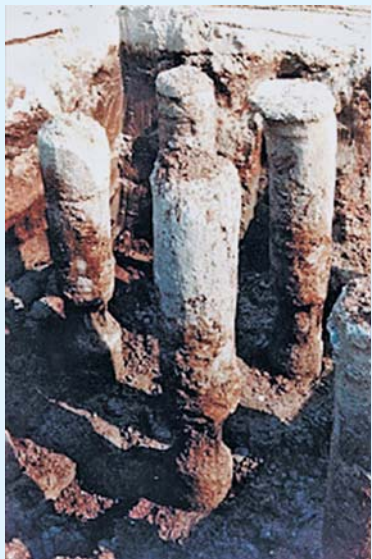
Рис. 1. Типичные дефекты буронабивных свай
