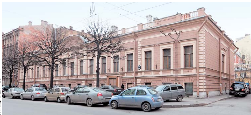
Компания «Интарсия» приступит к реконструкции обособленного П.Н. Трубецкого — памятника архитектуры федерального значения. Ремонтно-реставрационные работы оцениваются в сумму около 54 млн рублей
