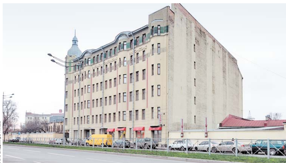
На Лиговском проспекте может быть построен 11-этажный бизнес-центр. В КУГИ ищут пути для расторжения договора доверительного управления объектом недвижимости, после чего участок выставят на торги
