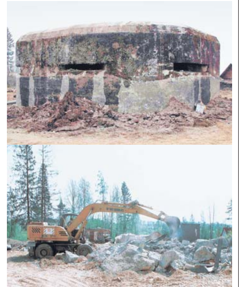
Демонтаж железобетонного дота в садоводстве
