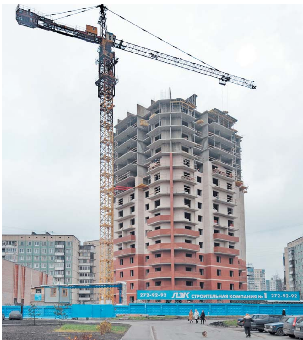
Жилой дом со встроенными помещениями на Ленской улице «ЛЭЖ Истейт» обещает сдать в эксплуатацию в октябре следующего года
