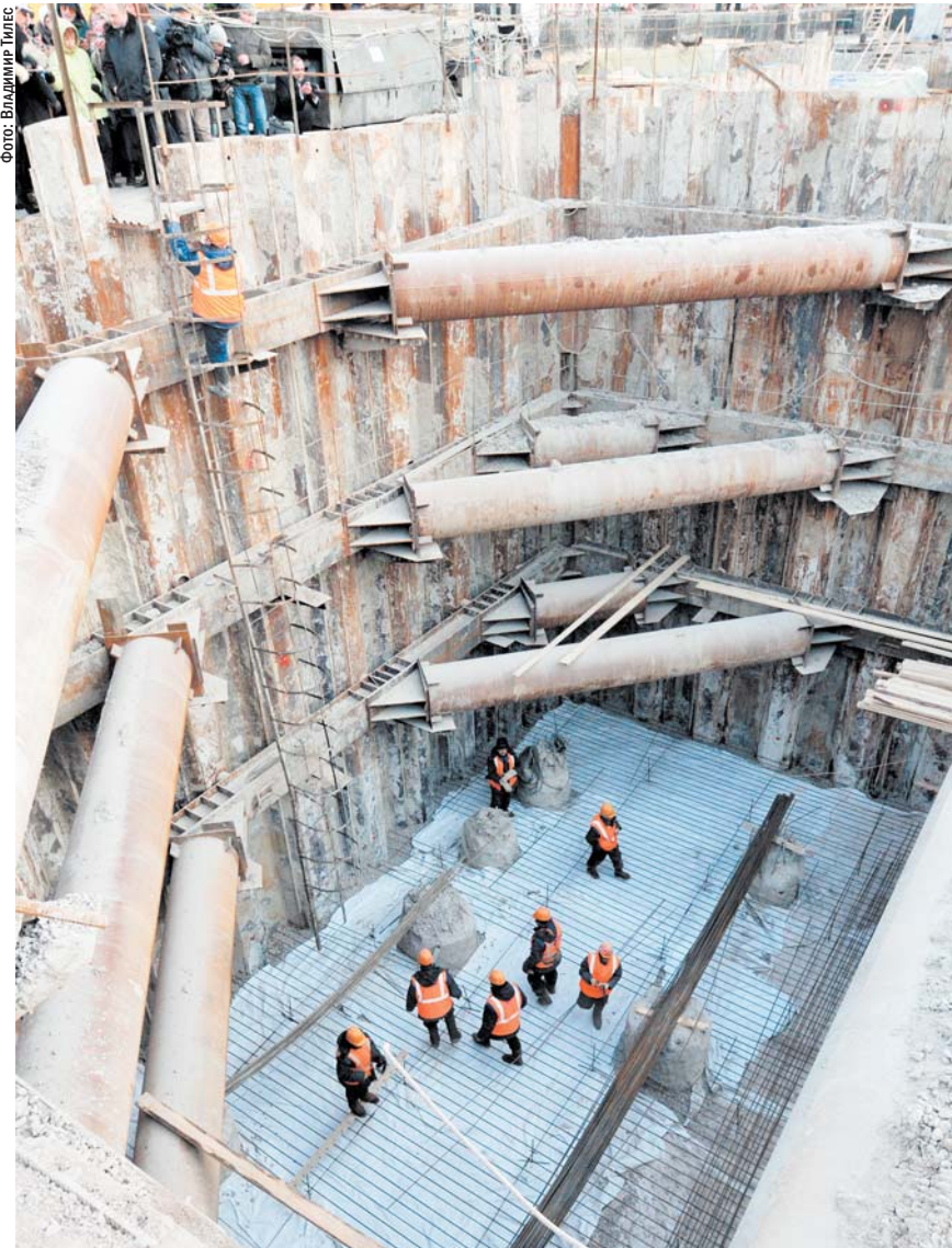
Специалисты возвели «стену в грунте» с использованием новой технологии «джет граунтинг»
