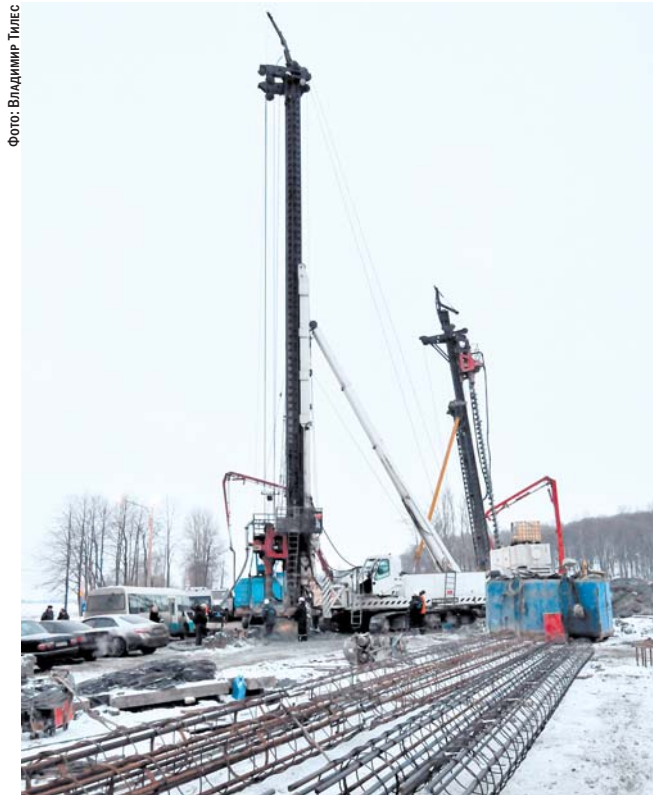
Устройство свайного фундамента
