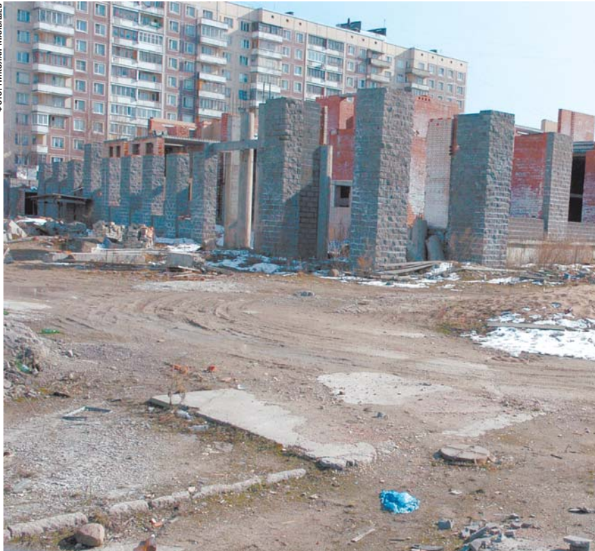
→ Самый крупный по строительным объемам объект, включенный в лот, находится на Гражданском проспекте. Пока возведен только первый этаж дома
