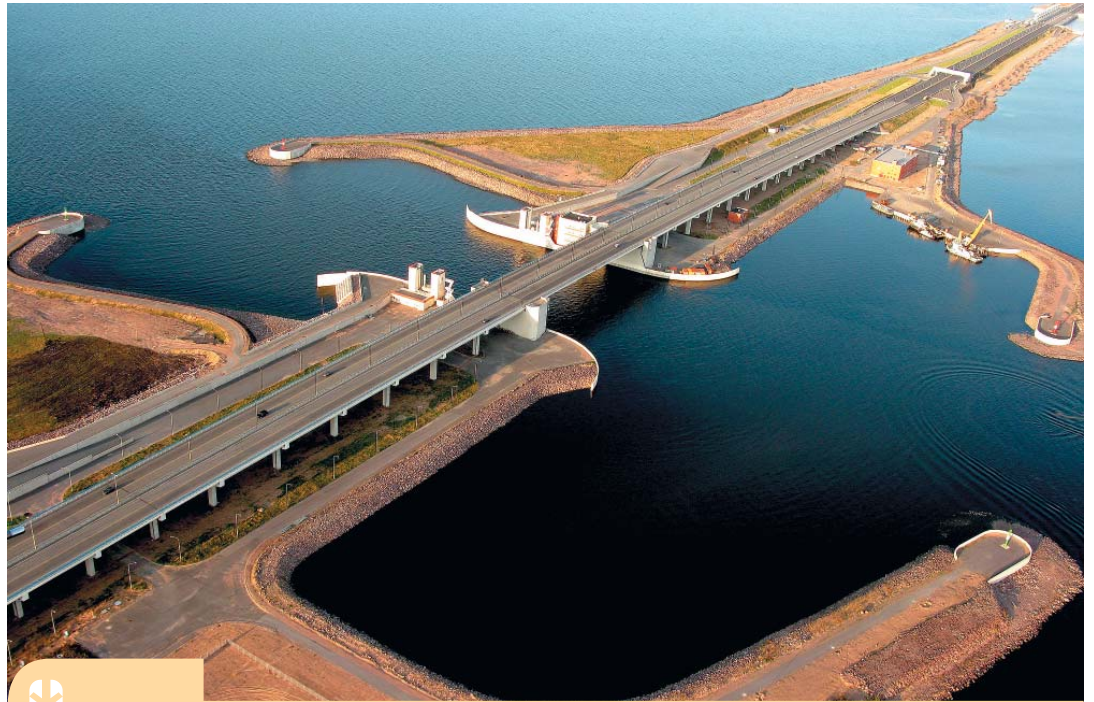
Строительство объектов на Петербургской дамбе (ЗАО «Энергострой»)
