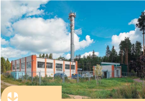
Газовые автономные котельные, г. Сердолово (ООО «Цементно-бетонные изделия»)
