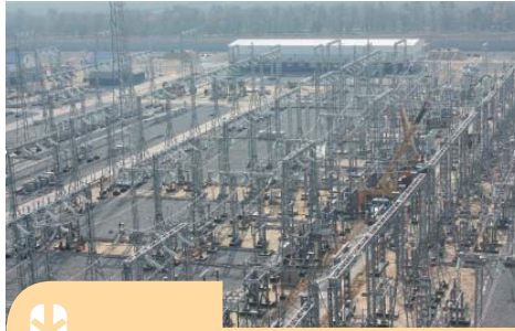
Строительство объектов в Краснодарском крае, подстанция 220 кВ «Вышестеблиевская» (ЗАО «Энергострой»)
