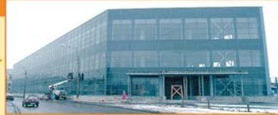
торговый центр на пр. Энергетиков, 19
