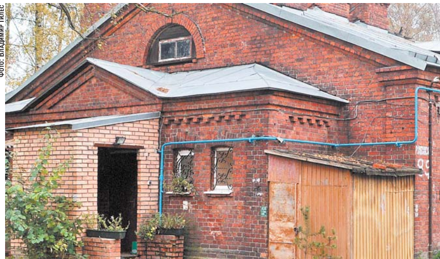
Большинство исторических зданий сейчас приспособлено под жилые дома
