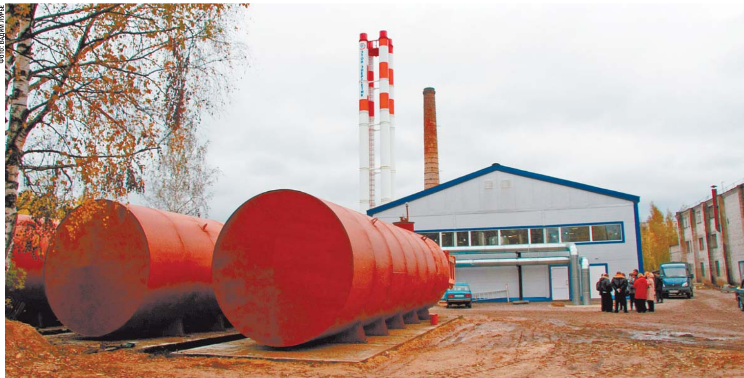
→ Новая центральная котельная стала еще одним важным шагом в коммунальном преобразении Луги
