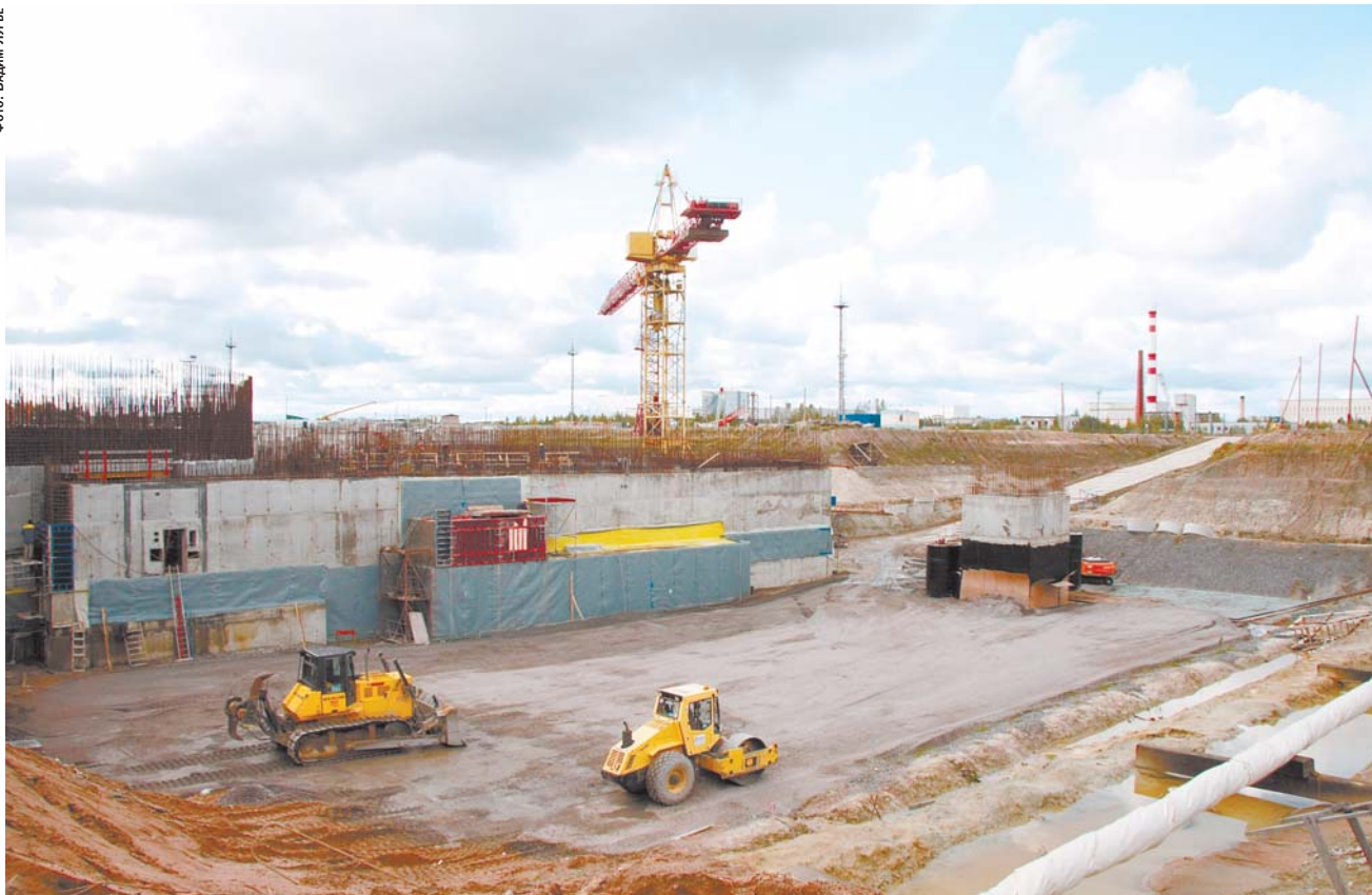
На данный момент завершено устройство фундаментной плиты здания реактора первого энергоблока
