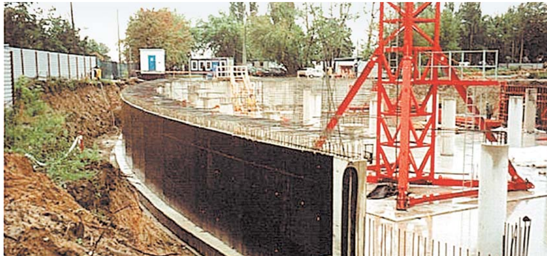
Для достижения непрерывности защиты жидкая мембрана Bituthene LM должна твердеть в течение 24 часов
