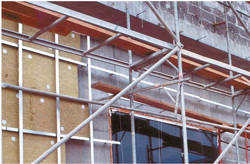
Теплоизоляция из каменной ваты способна выдерживать температуру до 1000 °С
