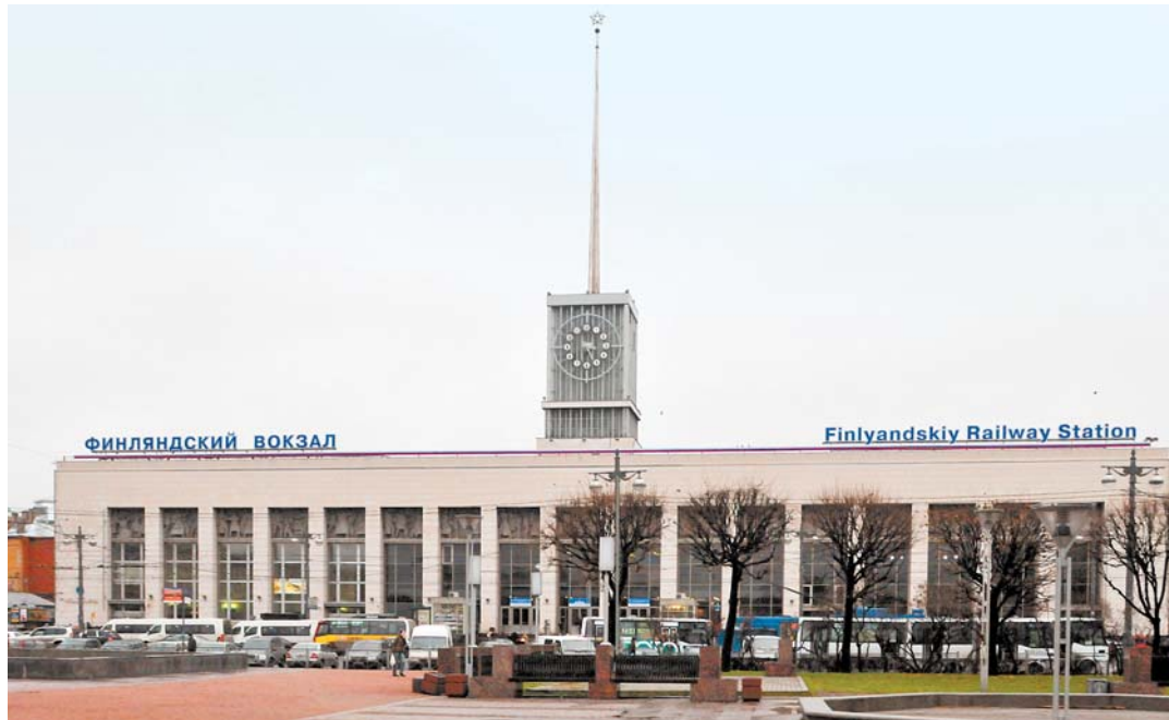
Работы по преобразованию Финляндского вокзала рассчитаны на длительный период и разделены на три фазы
