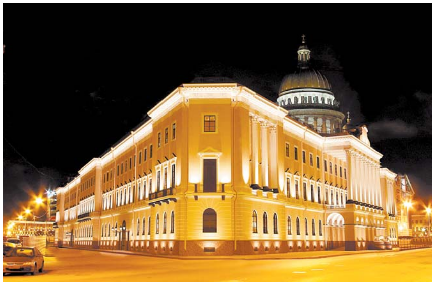
Весной этого года жители и гости города увидят Дом со львами обновленным после снятия строительных лесов
