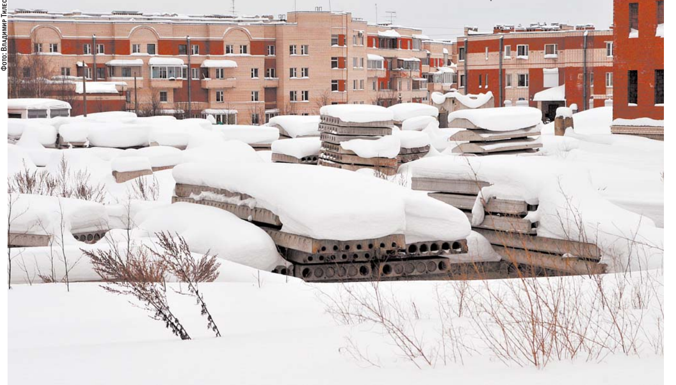
➔ Осенью прошлого года городские власти передали заваленный стройматериалами пустырь на улице Архитектора Данини (восточнее дома 11/16, лит. А) в Пушкине жилищно-строительному кооперативу. Возводить жилой корпус будут пострадавшие дольщики
