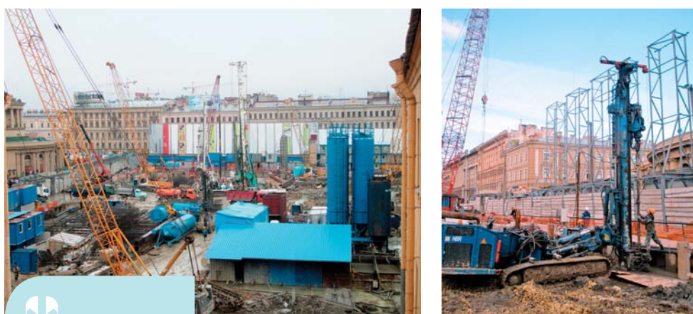
Нулевой цикл строительства торгово-офисного комплекса «Стокманн» со встроенным трехуровневым подземным паркингом
