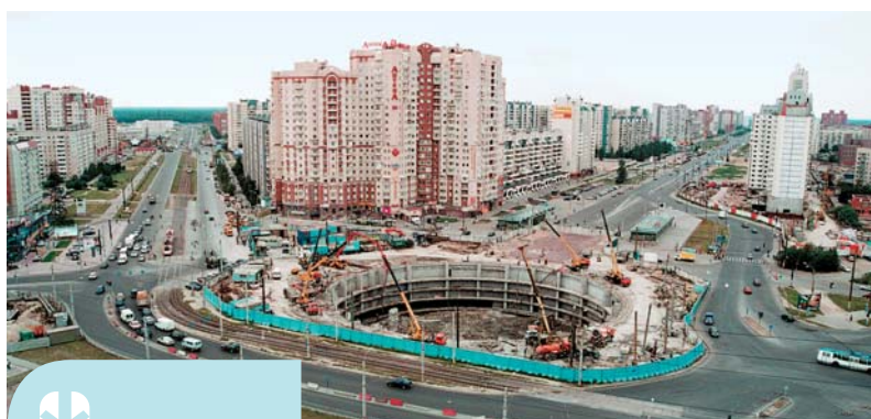
ТРЦ «Атмосфера» на Комендантской площади. Строительство пятиэтажного подземного паркинга
