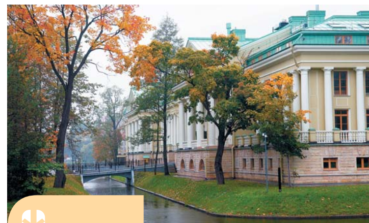
Жилой комплекс на 2-й Березовой аллее
