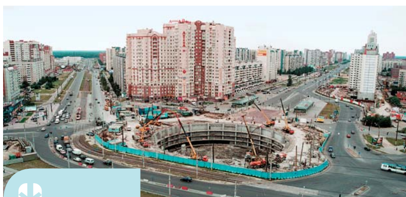
ТРЦ «Атмосфера» на Комендантской площади. Строительство пятиэтажного подземного паркинга
